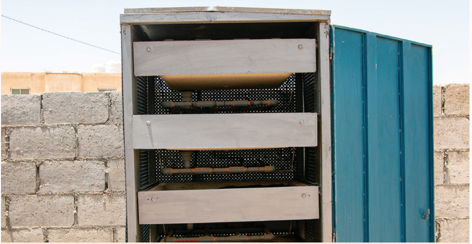
نظام معالجة المياه الرمادية
