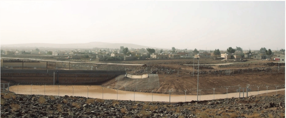
بركة لتجميع مياه الأمطار- محافظة المفرق
